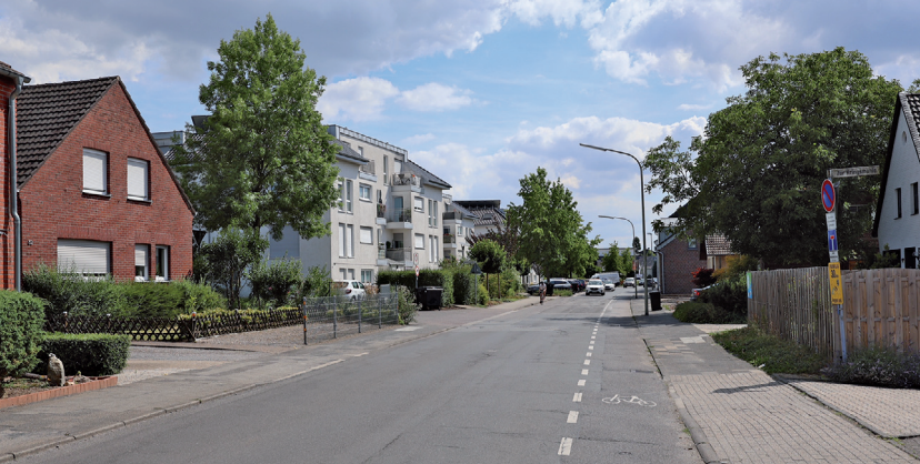
Die Bahnhofstraße wird durch eine Komplettsanierung mit Begleitgrün zu einer attraktiven Zufahrt ins Stadtzentrum.
